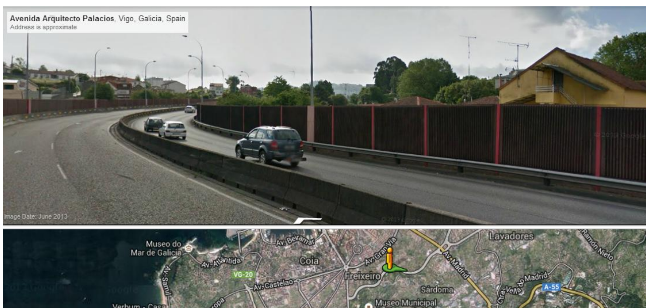
Figura 37. Pantallas acústicas na Avenida do Arquitecto Palacios
