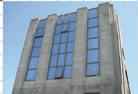
O acondicionamento do edificio da antiga Escola de hostalaría, para o seu uso como centro de fomento do emprendemento, foi realizado polo Programa municipal de emprego BIAL.
