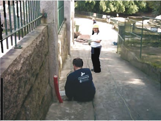
A nova especialidade de fontanería-electricidade está a permitir actuacións de mellora en instalacións que xa estaban obsoletas
