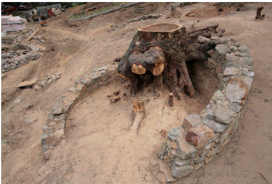
Eliminación dunha árbore no interior dunha das casas
